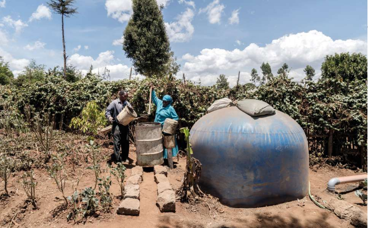
L'impianto "a palloncino" è una delle tecnologie diffuse dai progetti di cooperazione internazionale per la produzione domestica di biogas. © Alessandro Grassani, 2019
